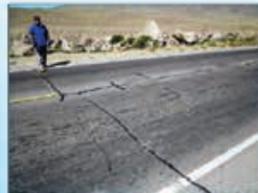
Medición de fallas en el pavimento.
