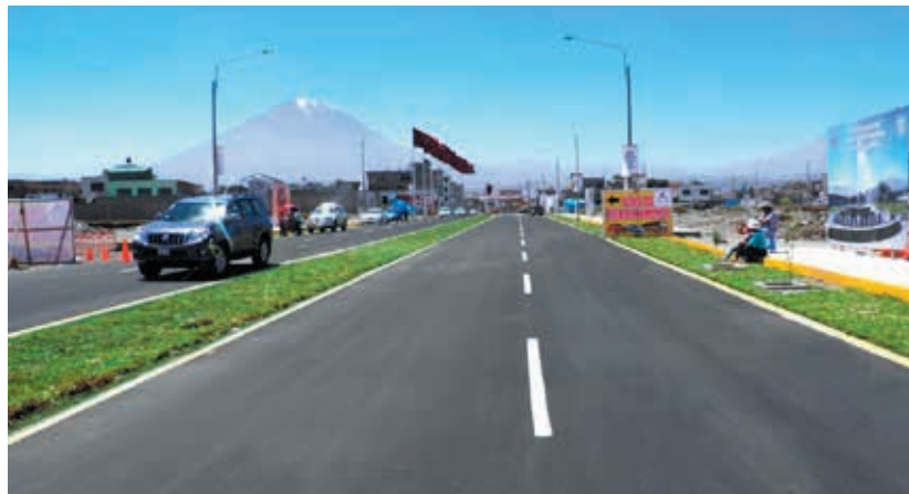
Autopista de Cerro Juli
