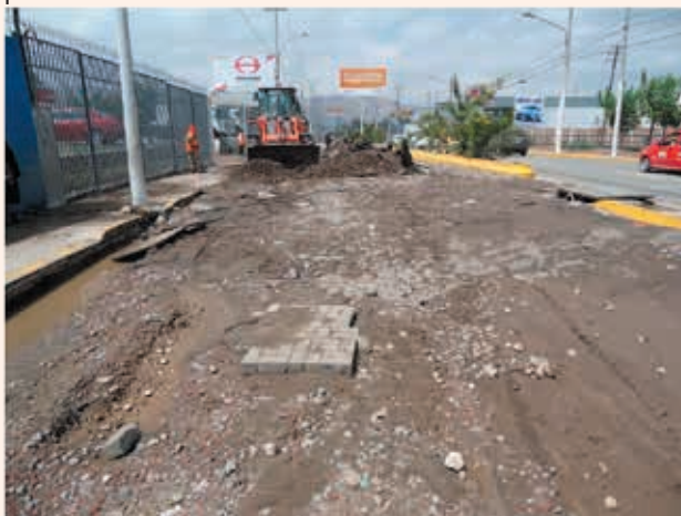
Su resistencia probada por el paso de camiones pesados.
