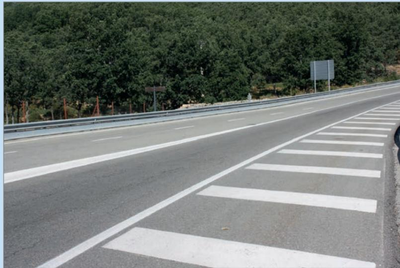
Foto 5. Barrera de seguridad con sistema para protección de motociclistas (Fuente: SIMEPROVI).
