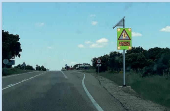
Foto 8. Ejemplo de señalización actuada en cruce inteligente. (Fuente: DGT).
