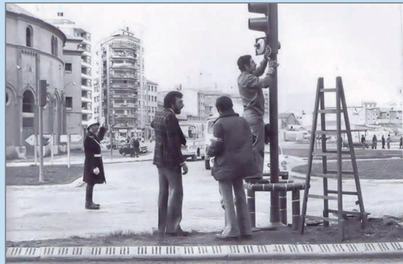
Foto 2. Trabajos en una de las primeras centralizaciones semaforicas que realizó la DGT (ciudad de León). (Fuente: DGT).
