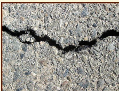
Ilustración 3. Grieta en el pavimento. Fuente: Pixabay
